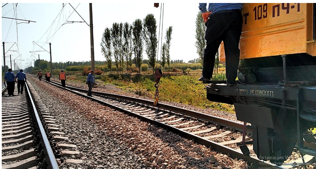
Рисунок 7 – Процесс надвигки рельсовой плети на перегоне Назарбек-Далагузар
