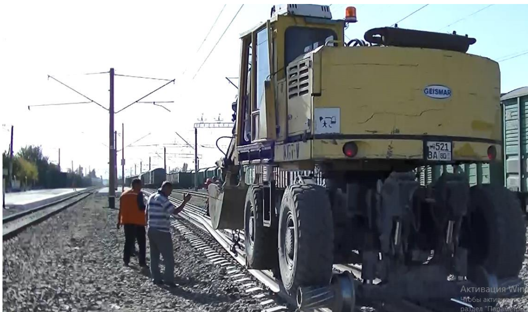
Рисунок 8 – Процесс надвигки рельсовой плети на станции Рахимова
